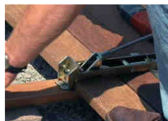
Insertion en puissance de la griffe dans une lame déjà en place
