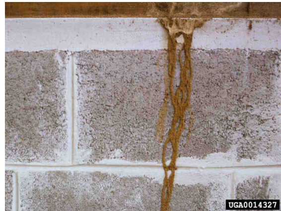
Tunnels fabriqués par les termites pour se protéger de la lumière (Source : USDA Forest Service Archive, USDA Forest Service, Bugwood.org)
