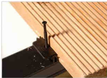
Pose de la lame suivante et vissage
